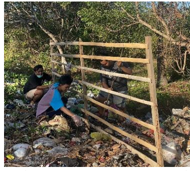
Gambar 3. pemasangan sekat TPS
