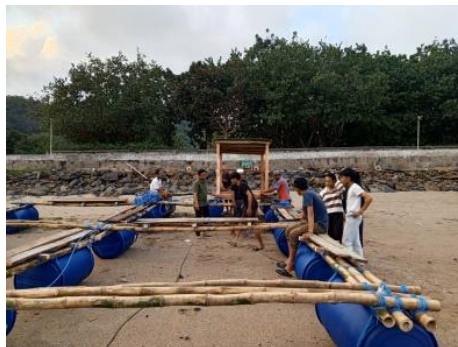
Gambar 13. Pembuatan keramba
