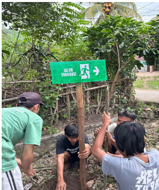
Gambar 4. Pemasangan Rambu Jalur Evakuasi
