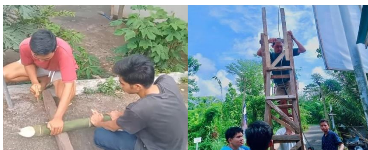
Gambar 10. Pemasangan Lampu Jalan
