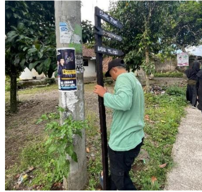
Gambar 2. Pemasangan Plang Penunjuk Arah
