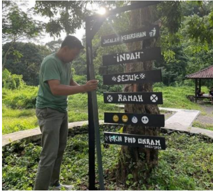
Gamba 1. Pemasangan Plang Sapta Pesona
