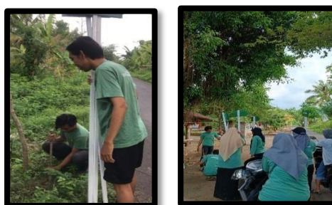
Gambar 3. Pemasangan rambu jalur evakuasi
