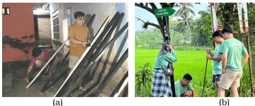
Gambar 4. Pembuatan plang (a), peletakan plang jalur evakuasi (b)
