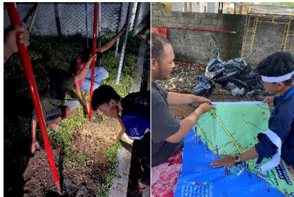
Gambar 16. Penggalian dan Pemasangan Spanduk Peta
