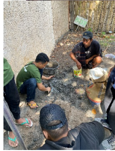
Gambar 14. Proses Tahap Penggalian Lubang Pemasangan Plang Petunjuk Arah
