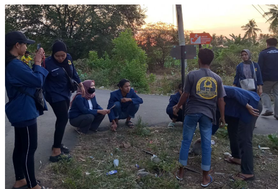
Gambar 7. Pemasangan rambu jalur evakuasi di Pekendangan
