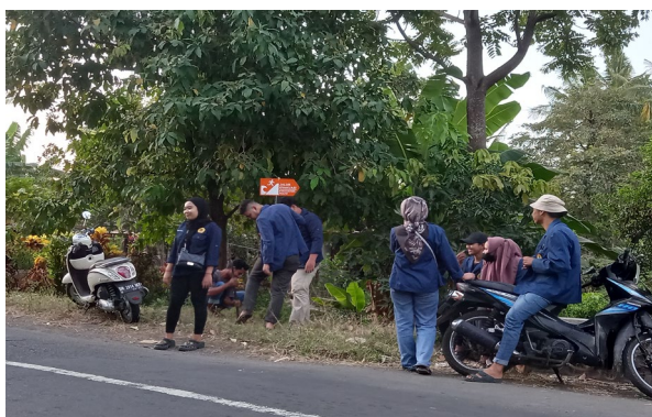
Gambar 6. Pemasangan rambu jalur evakuasi di Pekendangan
