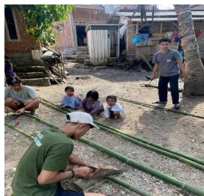
Gambar 6 Proses pemotongan bambu sebagai tiang plang
