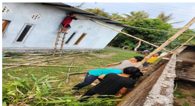
Gambar 4. Pembuatan Tiang Rumah Bibit Aren
