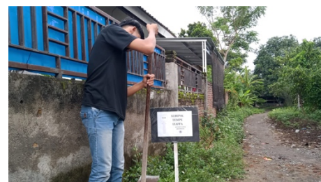
Gambar 10. Pemasangan Papan Penunjuk Jalan
