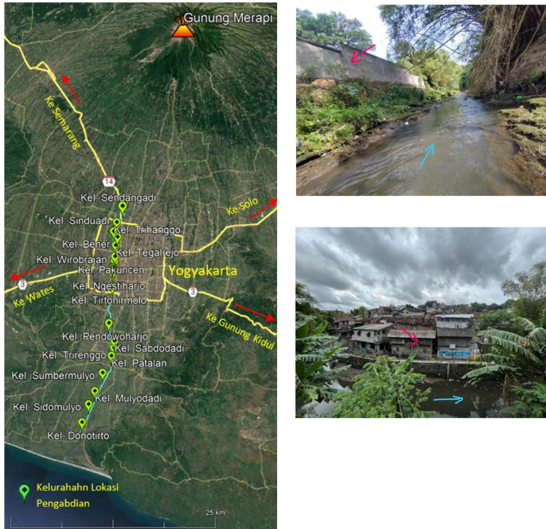
Gambar 2. Lokasi pengabdian dan contoh kondisi bangunan di tebing sungai
