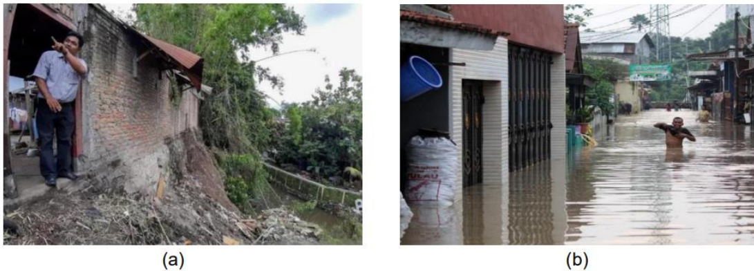
Gambar 1. a) kondisi rumah dibantaran yang longsor, dan b) banjir Sungai Winongo
