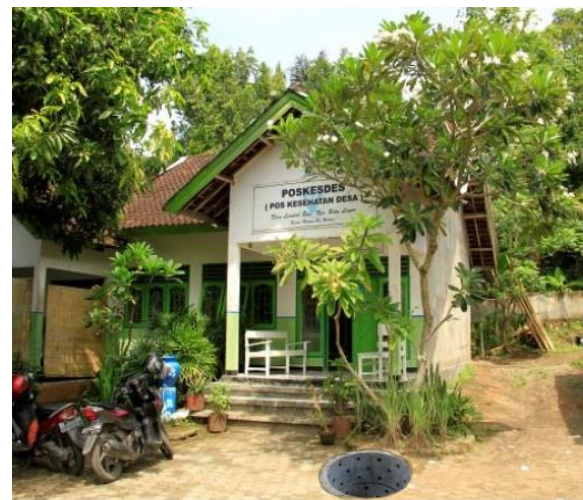
d. Sumur resapan di halaman kantor Poskesdes (sebelum di pasang penutup)
