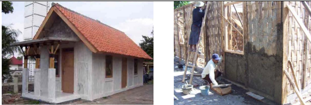
Gambar 4. Aplikasi plester pada anyaman dinding bambu sumber: Modul Pelatihan Bambu Plaster, Widyowijatnoko, A. dan Mustakim
