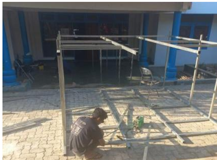
Gambar 1. Proses Pembuatan Rangka Rumah Pengering Rumput Laut
