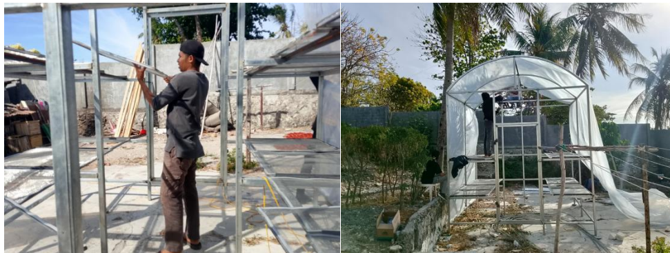
Gambar 3. Proses Perakitan Rumah Pengering rumput Laut
