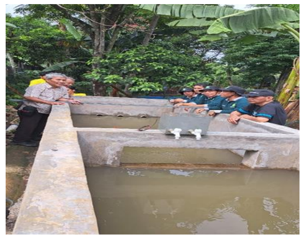
Gambar 9. Praktek pengoperasian alat elektrokoagulasi
