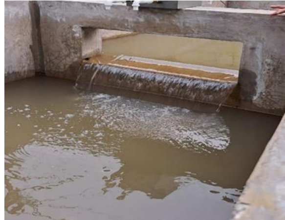
Gambar 4. Bak proses elektrokoagulasi
