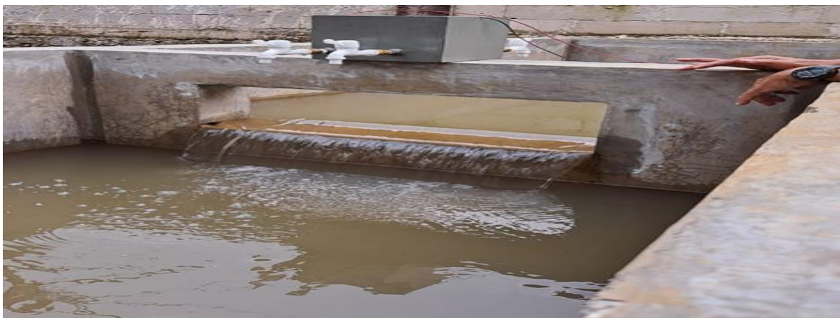
Gambar 5. Tata letak pembangkit senyawa koagulan \text{Al}(\text{OH})_3 pada bak proses elektrokoagulasi
