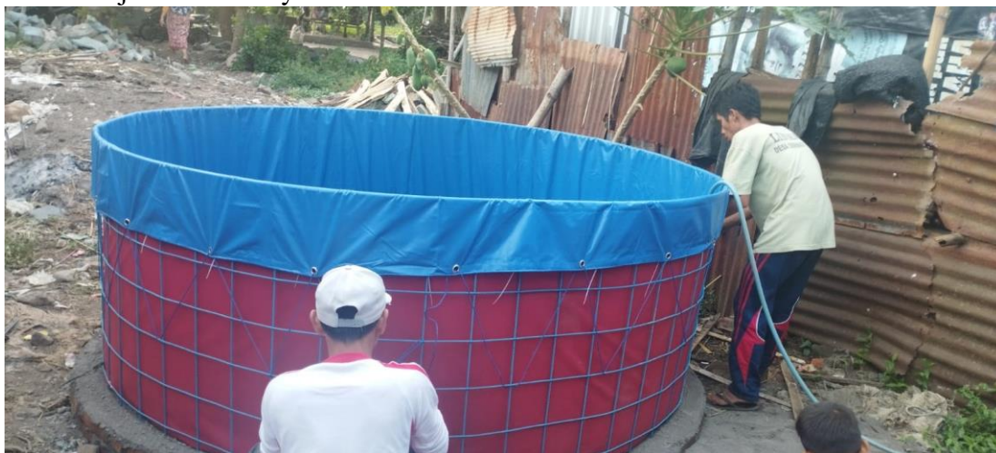
Gambar 3. Pembuatan Konstruksi Kolam Terpal Bersama Kelompok Tani Dusun Karang Anyar, Desa Gerimaks Indah
