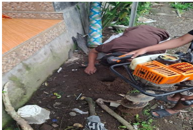
Gambar 2. Pembuatan Lubang Resapan Biopori
