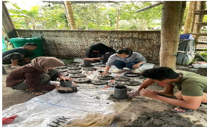
Gambar 1. Pembuatan Penutup Lubang Biopori
