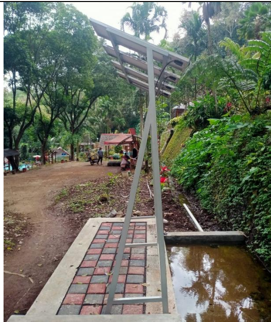
Gambar 7. Rangka instalasi hidroponik bertenaga surya
