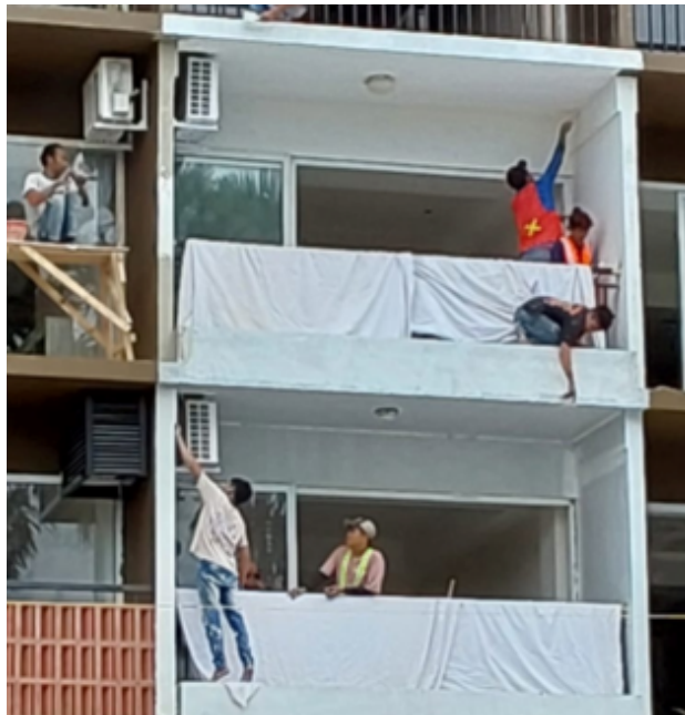
Gambar 4. Proses Keamanan Dalam Reparasi Gedung Bertingkat
