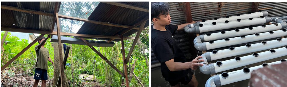
Gambar 4. Penambahan Atap Pelindung dan Pipa Hidroponik
