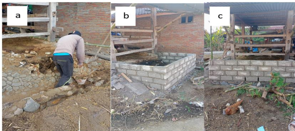
Gambar 4a, 4b, 4c. Pembuatan Bak Pengolahan Kotoran hewan Sapi oleh warga Dusun Mongge-2 (23 Oktober 2023)
