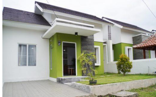
TAMPAK DEPAN BANGUNAN
