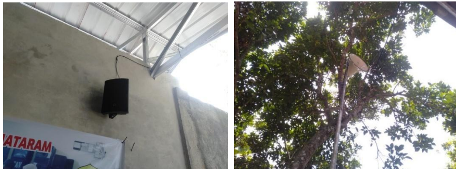
Gambar 14. Hasil Pemasangan speaker kolom dan speaker corong
