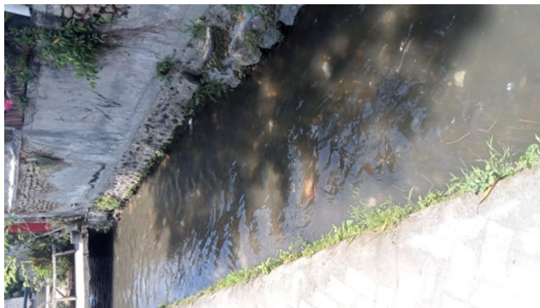
Gambar 1. Parit yang digunakan sebagai tempat pembuangan sampah
