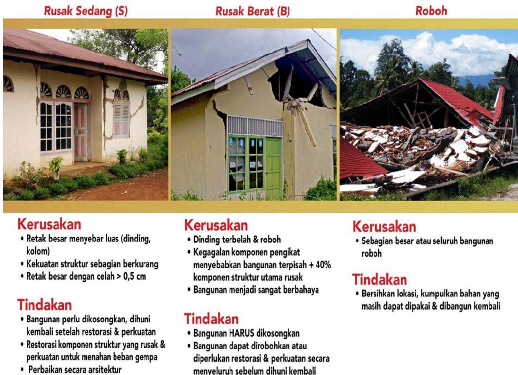
Gambar 2 Bangunan Rusak Sedang Sampai Roboh Akibat Gempa dan Tindakan yang Dilakukan
