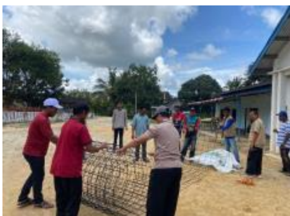
Gambar 3. Proses pemasangan wermes
