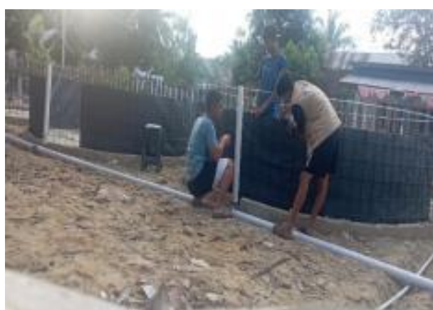
Gambar 5. Pemasangan terpal dan instalasi air
