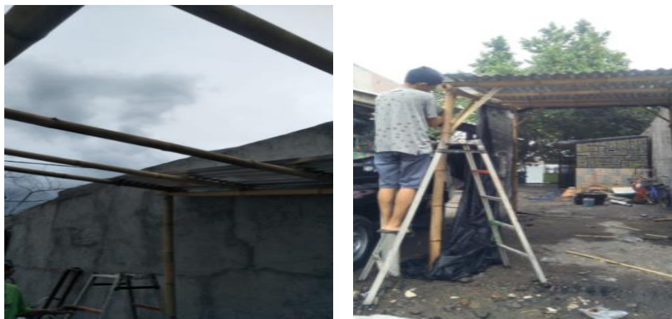
Gambar 2. Pembuatan atap untuk naungan budidaya udang vanamei
