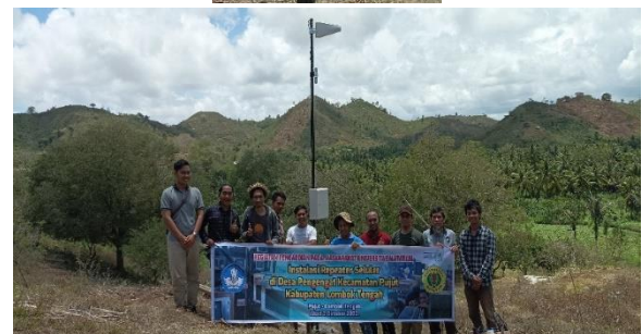
Gambar 13. Hasil Akhir Pemasangan peralatan repeater
