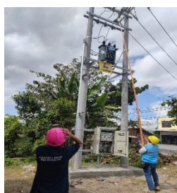
Gambar 4. Pemasangan Fuse Tube pada Bodi Fuse Cut Out
