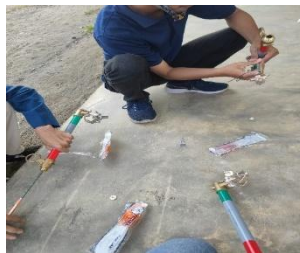
Gambar 3. Fuse link dipasangkan pada fuse tube
