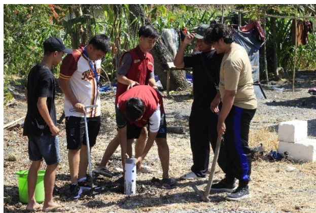
Gambar 3. Pemasangan Lubang Resapan Biopori di Desa Dukohkidul.
